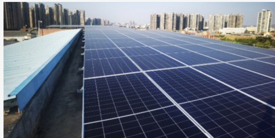
惠州豪鹏 0.88MWp 光伏项目于 2025 年 11 月顺利完工并投入使用，助力能源结构优化
