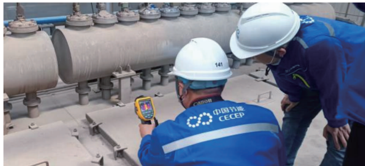
测量除尘器保温情况，现场检验锅炉漏风治理情况
