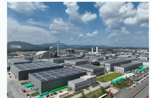
广西基地“源网荷储”一体化项目
