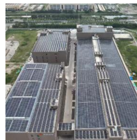
浙江华创光电材料有限公司 光伏发电项目
