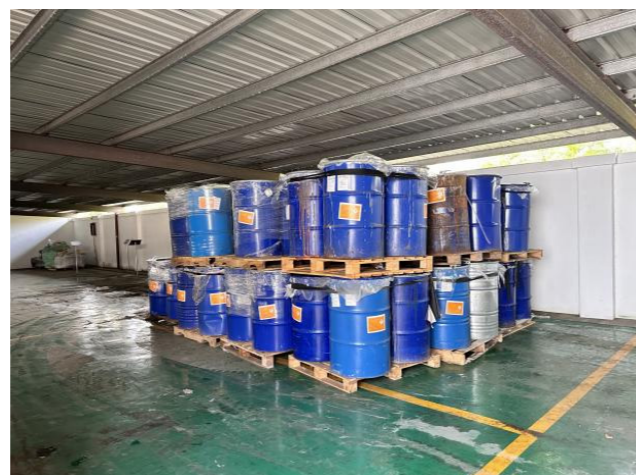
危险废物仓库
