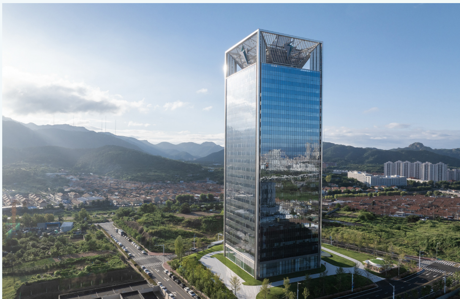
特来电总部大楼
