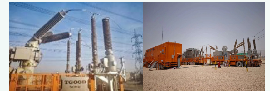
沙特132kV 移动式预制舱变电站建设项目
