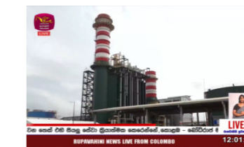
斯里兰卡 Kerawalapitiya 二期 350MW 联合循环电站项目开机投运
