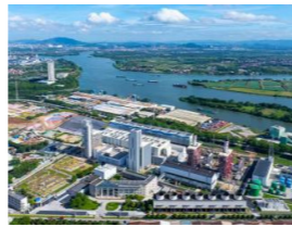
深燃高埗项目第二台机组通过 168 小时试运行
