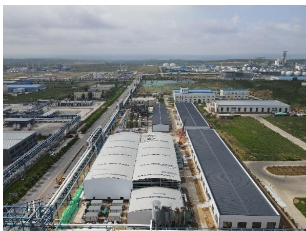
陕西榆横高盐废水运营项目
