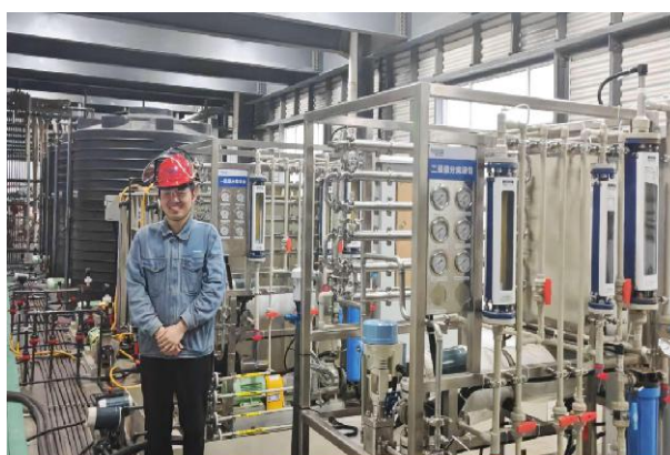
广西钦州某镍离子价值回收项目
