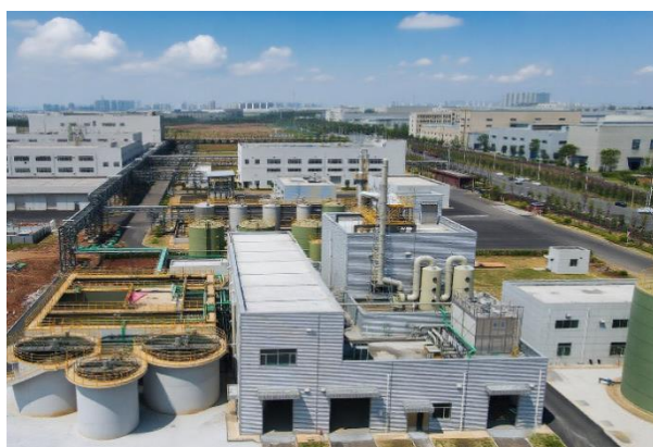
湖南某大型银粉银浆生产基地废水处理项目
