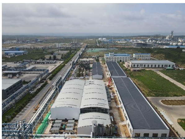
陕西榆横高盐废水运营项目
