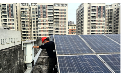
员工宿舍安全隐患排查
