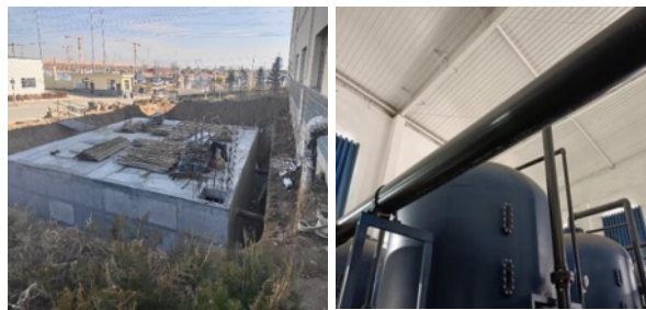
图表 改进后的雨水收集池（左）和机械过滤器（右）
