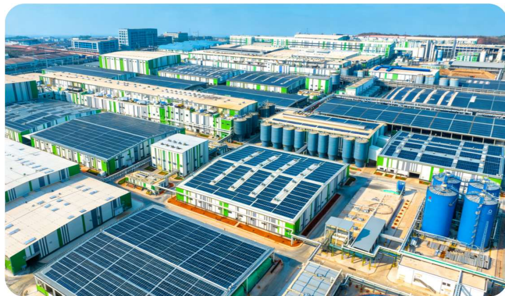
图为南宁园区屋顶式光伏项目
