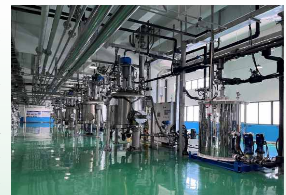
三元锂电池正极材料项目现场
