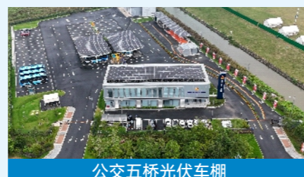
公交五桥光伏车棚
