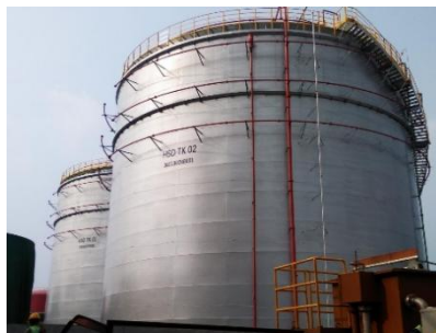
孟加拉希拉杰甘杰电站项目油罐
