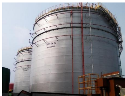
孟加拉希拉杰甘杰电站项目油罐
