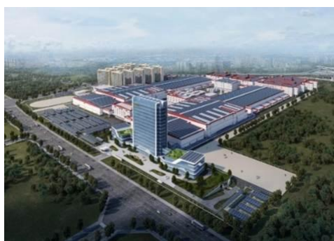
图 6：NCC 钢结构应用于高端电子厂房
