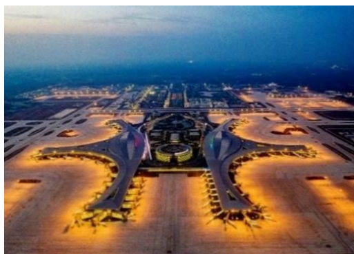
图 7：NCC 钢结构应用于大跨度公共建筑
