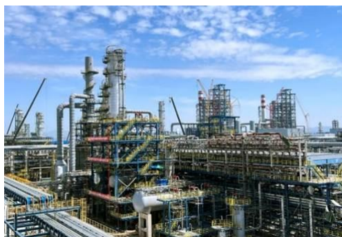
图 5：NCC 钢结构应用于石油化工领域
