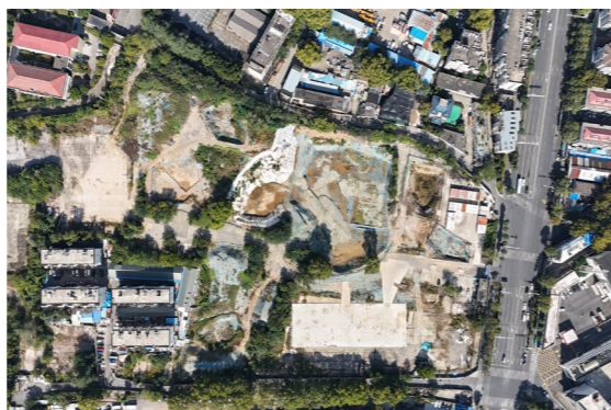
污染土壤修复工程区域俯视图
