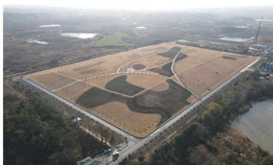
六合垃圾填埋场实景图
