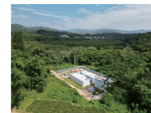
● 阳春市生活污水处理设施 全市打包建设项目
