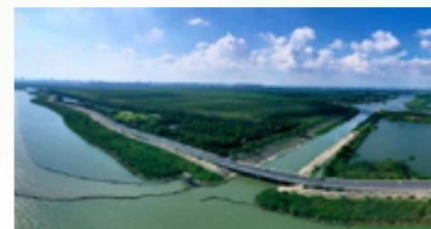
巢湖生态清淤及湿地修复一期工程
