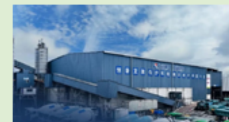
工程土方资源化利用
