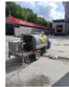
施工基坑水回用
