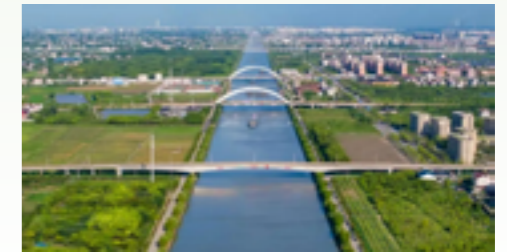
上海大治河生态廊道修复
