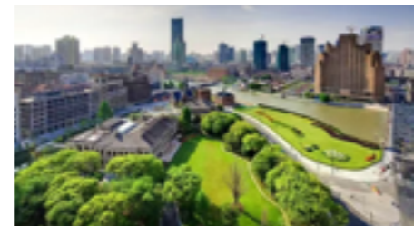
工程土方资源化利用
