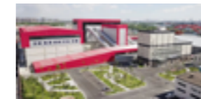
废水零排放搅拌站
