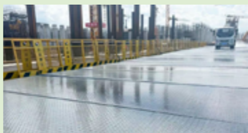
装配式钢栈桥板应用
