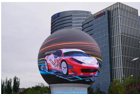
北京亦庄“瞰界·未来之眼”，外球直径达 14 米，内球为直径 10 米、1.95mm 透声半球幕、配置 32 座的 5D 飞行影院，分辨率达 8K*8k
