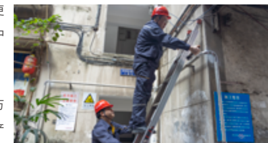
重庆燃气北碚分公司开展燃气管道老化更新改造施工
