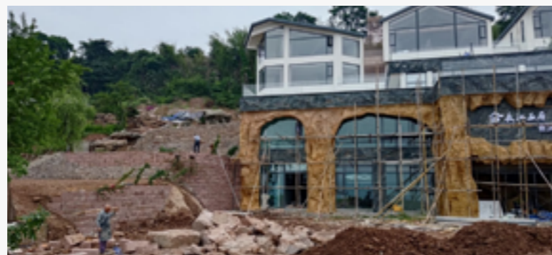
石盘村乡村旅游扩建项目燃气改造现场
