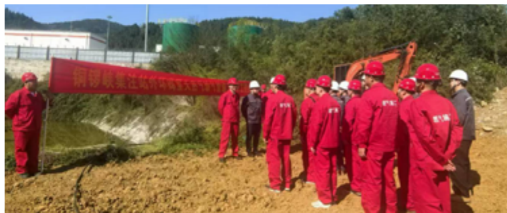
铜锣峡集注站外环阀室天然气输气管道工程开工建设
