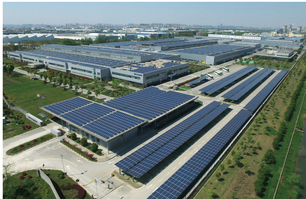
屋顶光伏发电项目
