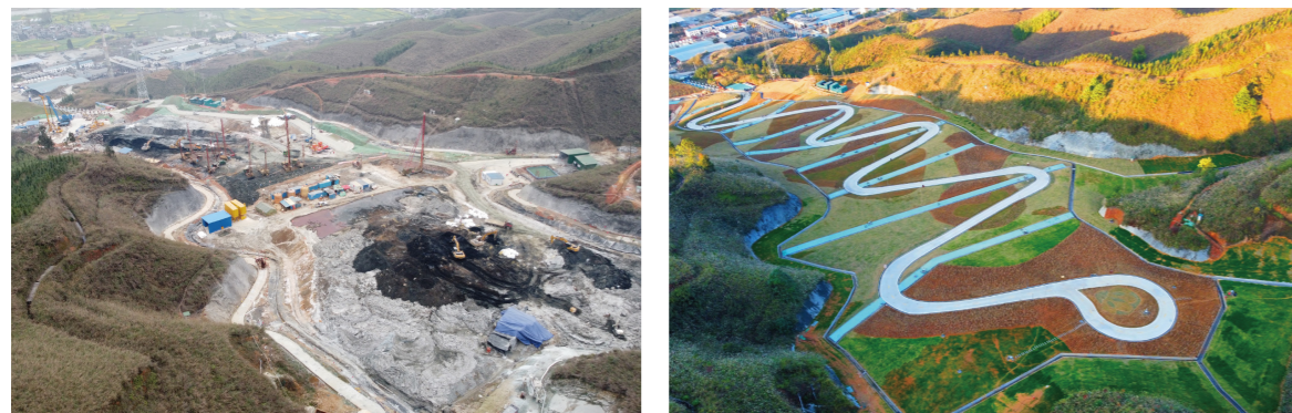
贵州项目土壤修复前后对比
