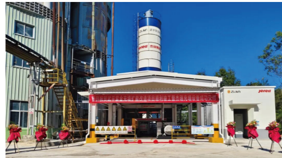
充填扩能改造项目
