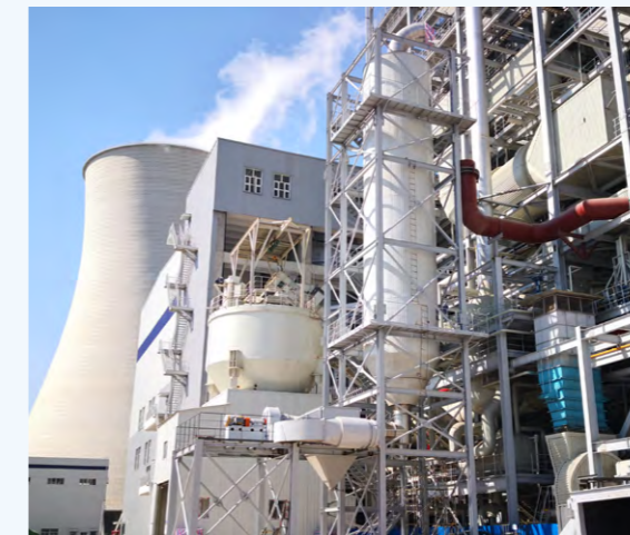
• 商丘废水零排放项目
