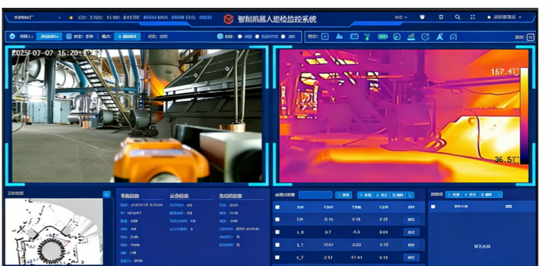
智能机器人高炉高风险巡检监控系统
