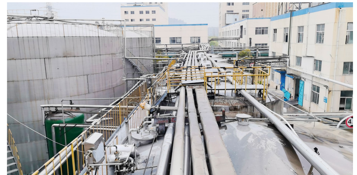
储罐进口控制管路图
