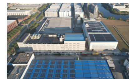
光伏发电设施
