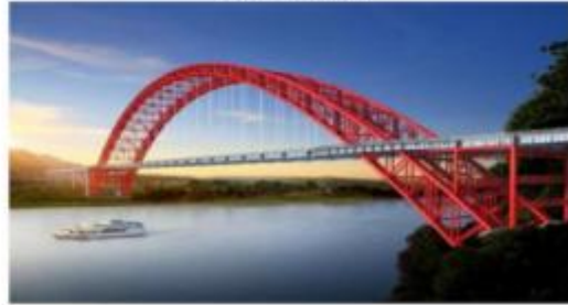
图例：四川犍为岷江特大桥
