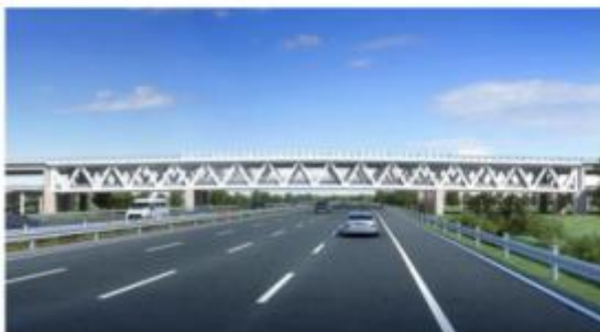
图例：苏州星港街大桥
