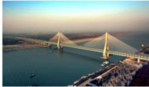
图例：天兴洲长江大桥
