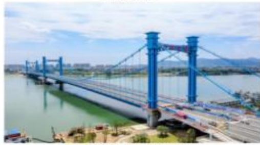
图例：襄阳凤雏大桥
