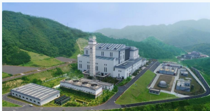
惠州市生態環境園生活垃圾焚燒發電項目全景圖
