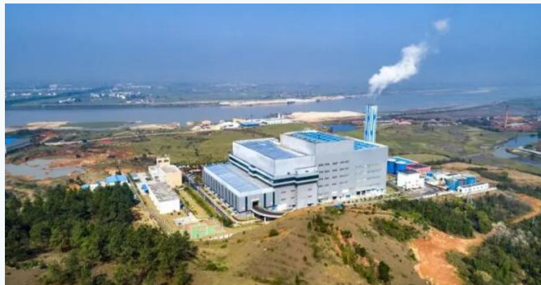
南昌泉嶺垃圾焚燒發電廠
