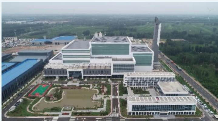
新鄉垃圾焚燒發電項目全景圖
