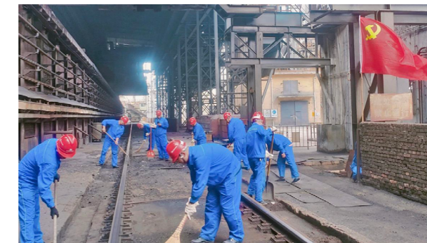
焦化厂焦化三车间，组织全体党员开展了“清理焦粉焦块，筑牢安全防线”专项现场治理志愿服务活动。
