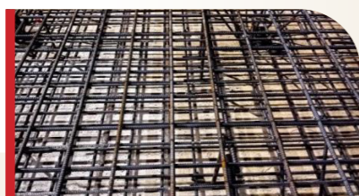
废钢筋利用加工措施筋
