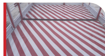
废旧模板做水平洞口防护
