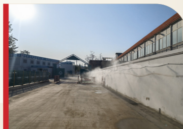
现场主要道路采取硬化措施
