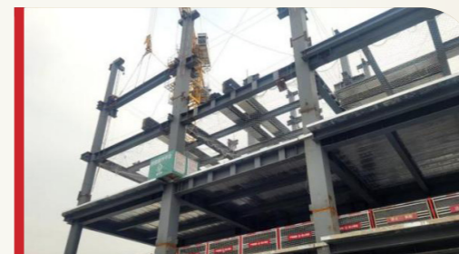
焊接设置遮光措施
