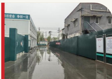
施工现场周边标准化围挡
