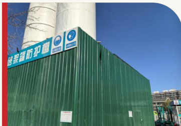
设置封闭式砂浆罐
