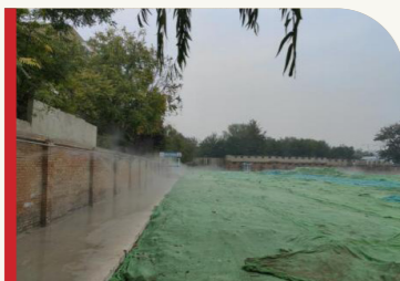
裸土采用防尘网苫盖
