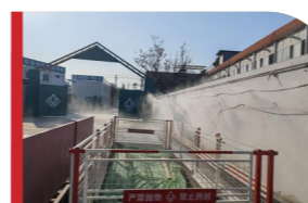
车辆冲洗设置沉淀池
