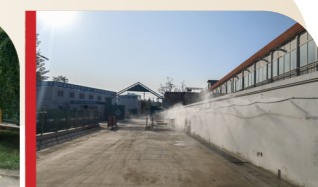
雨水设置排水沟排入雨水管道
