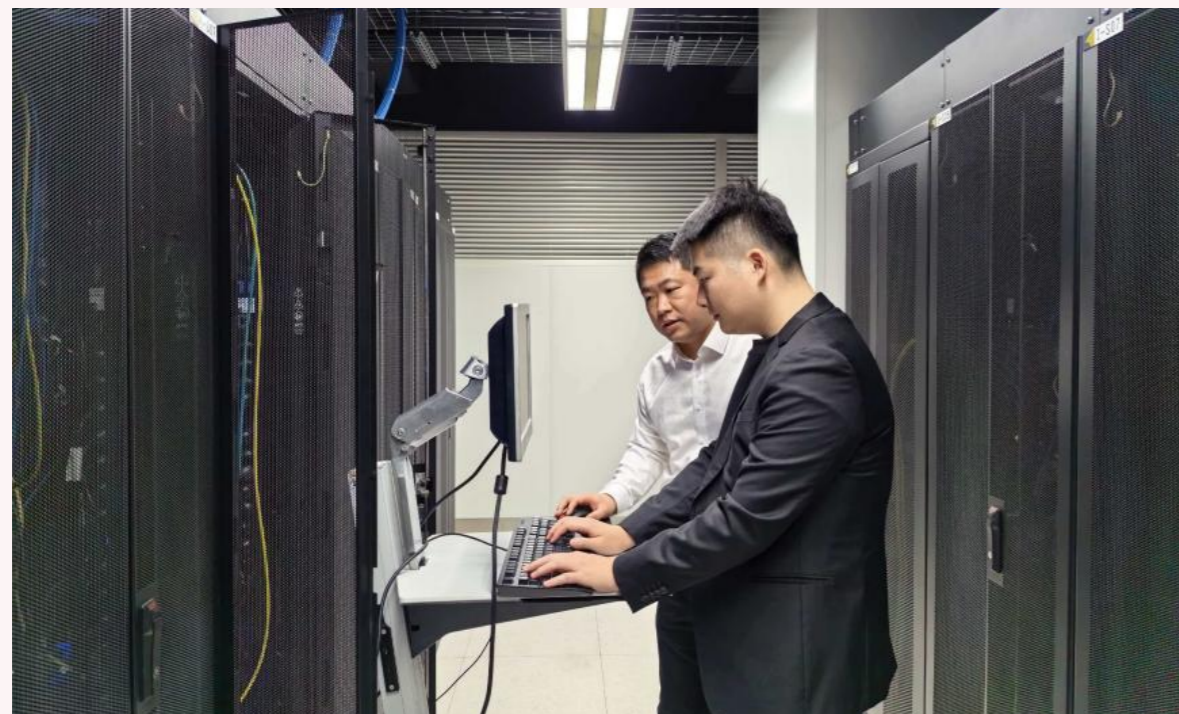
长城证券开展深沪交易所业务测试暨公司新 IDC 机房灾备应急演练
