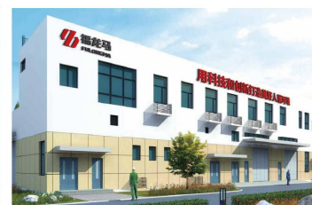
餐厨垃圾收运处置厂
