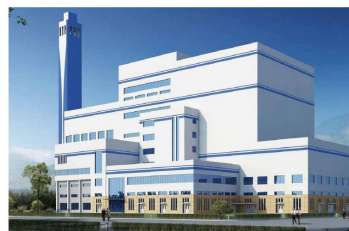
生活垃圾焚烧发电厂
