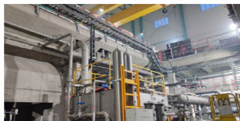
硫磺制酸及余热发电改扩建项目
