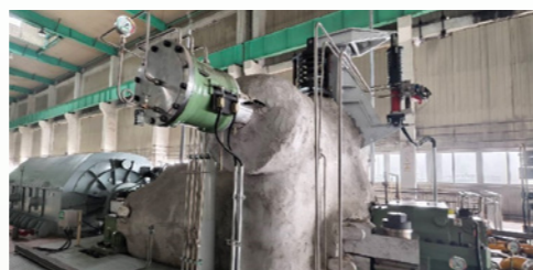
供热站水泵改造项目
