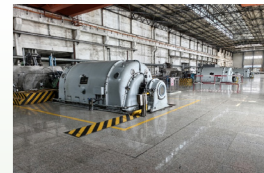
高能效锅炉升级项目
