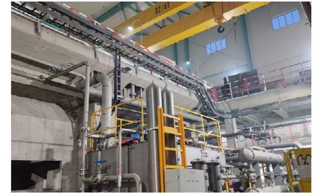
硫磺制酸及余热发电改扩建项目
