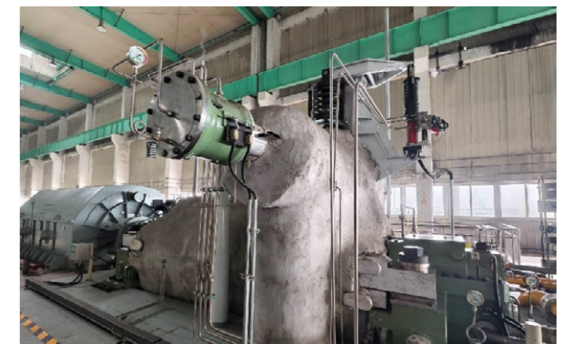
供热站水泵改造项目
