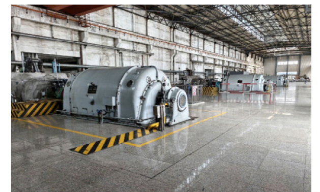
高效锅炉升级项目
