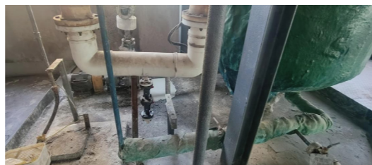
将固体母液釜气相管U型弯处的排液阀更换为双阀
