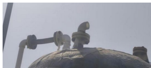
甲叉三楼Y计量罐V1006软连接法兰处因漏液更换与软连接相连的PP弯头
