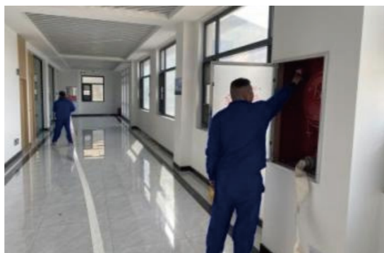
应急人员进行临时处置
