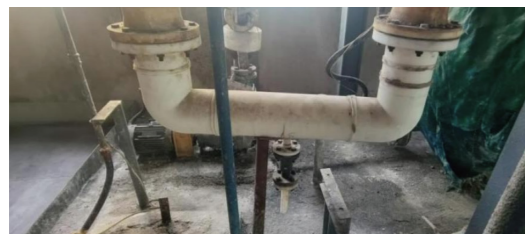
将固体母液釜气相管U型弯处的排液阀更换为双阀
