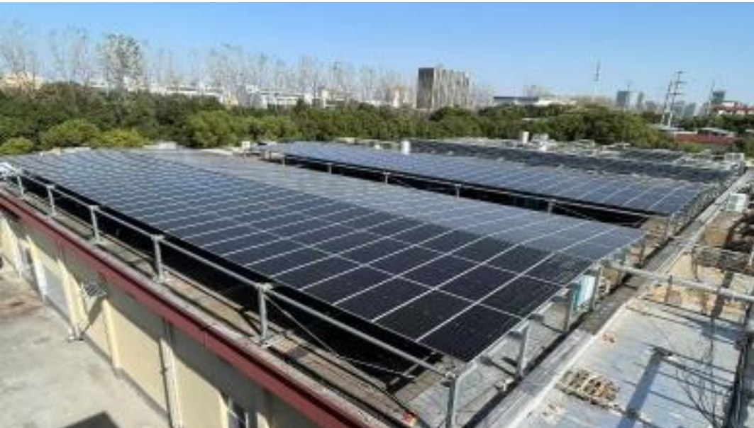
铺设屋顶光伏
