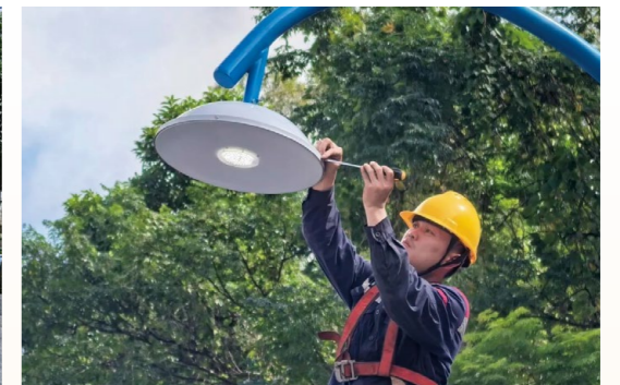
佛子公司为公路安装电灯
