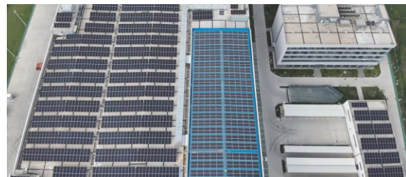
扬州物流配送中心光伏屋顶
