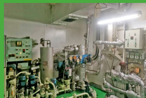
辅机燃油供油单元电加热器
