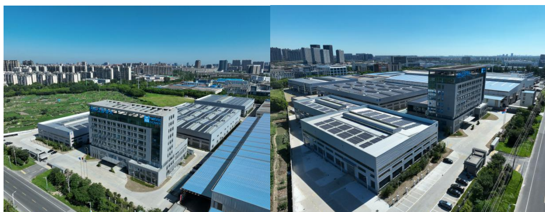
江苏华大办公区及厂房（中建环能东部制造基地）图
