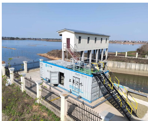
南昌县幽兰镇拦河西电排站
