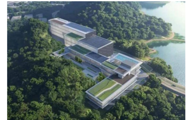
深圳某国家重点 AIDC 项目液冷二次侧系统集成
