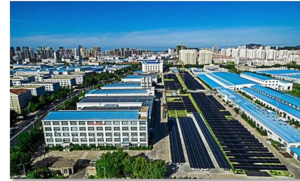
▲ 公司厂区光伏电站鸟瞰图
