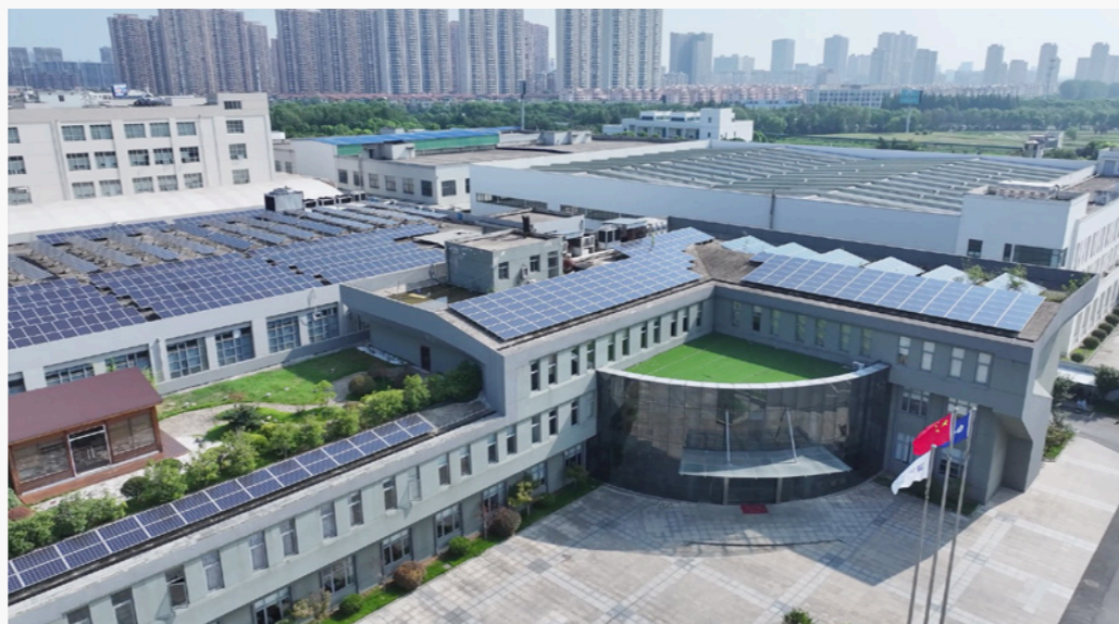
江苏无锡制造基地屋顶光伏
