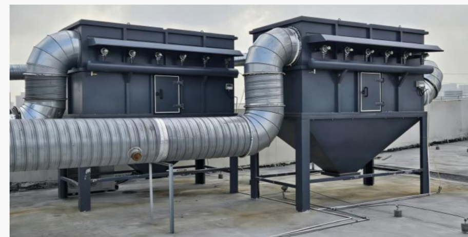
江苏无锡制造基地新增废气过滤器
