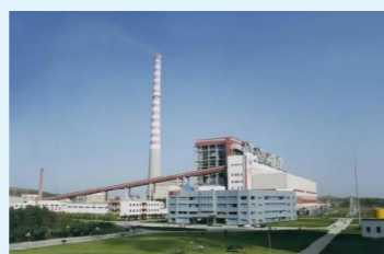
淮北国安公司机组超净排放改造
