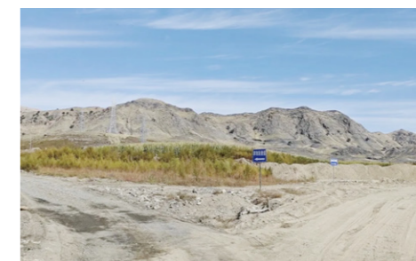
山片沟硫铁矿修建道路
