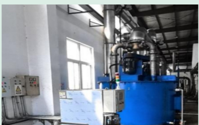
金山实验室废气处理系统
