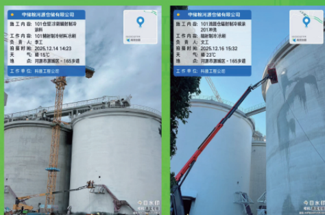
粮仓项目辐射制冷施工
